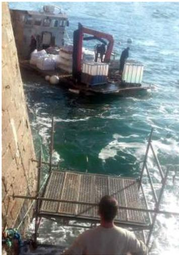
*L'Entreprise Quélin, mi-avril a entrepris la finition de la maçonnerie d u parapet ouest et sud du cinquième et dernier logis. Une reprise de chantier laborieuse : la livraison des matériaux par barge a été chaotique. Une mer houleuse, des problèmes techniques (grue) ont ralenti la mise en route des travaux. Mais il en faut plus à l'entreprise Quélin , très aguerrie au Fort pour baisser les bras !!!!!*
